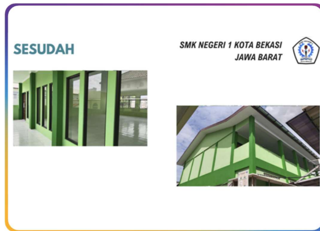
Gambar 3.10 Pembangunan Fisik dari Program SMK PK
