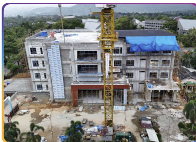
Gambar 3.4 Proses Pembangunan Gedung Laboratorium Penerima SBSN di Politeknik Negeri Padang
